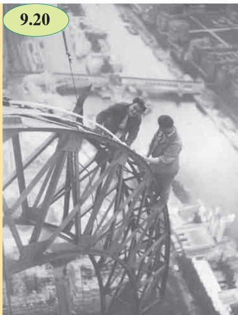
Ηλεκτρολόγοι τοποθετούν φώτα στον πύργο του Άιφελ στο Παρίσι. 1937.
