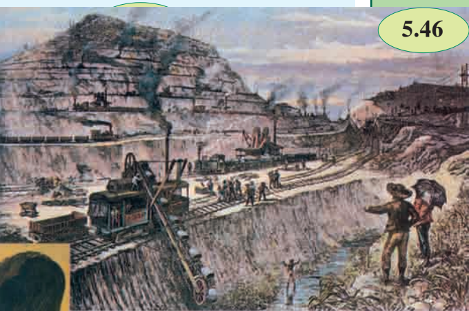
Σκίτσο με την κατασκευή της διώρυγας του Παναμά (1903). Στα τέλη του 19ου αιώνα άρχισε να κατασκευάζεται στο πιο στενό σημείο της Αμερικής η διώρυγα του Παναμά, με χρήματα από τις ΗΠΑ. Η περιοχή τότε ανήκε στην Κολομβία. Για να ελέγχουν τη διώρυγα, οι ΗΠΑ φρόντισαν να δημιουργηθεί ένα ανεξάρτητο κράτος, ο Παναμάς, που ήταν κάτω από τον έλεγχό τους.
