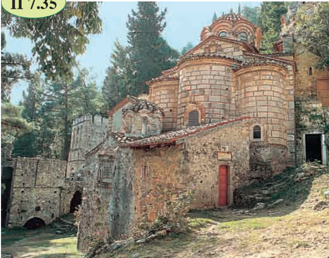
Η εκκλησία της Περιβλέπτου στο Μυστρά (Πελοπόννησος, Νομός Λακωνίας). Στις εκκλησίες αυτές μπορούμε να δούμε τα χαρακτηριστικά της αρχιτεκτονικής και της ζωγραφικής στην εποχή των Παλαιολόγων. Δεύτερο μισό 14ου αιώνα.
