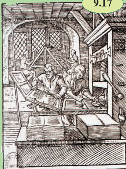
Τρία χαρακτηριστικά από βιβλίο που τυπώθηκε το 1574 και εικονίζει εργασίες σ' ένα τυπογραφείο. Στην εικόνα 9.16 φτιάχνονται τα φύλλα χαρτί, στην 9.17 η κάσα με τα τυπογραφικά στοιχεία και στην 9.18 η πρέσα (το πιεστήριο) όπου τυπώνονται τα φύλλα.
