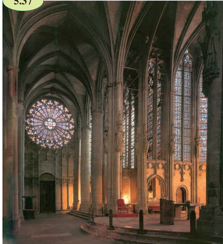
Το εσωτερικό του καθεδρικού ναού στην πόλη Καρκασόν της Γαλλίας. Βλέπουμε τα οξυκόρυφα τόξα που σχηματίζουν το θόλο της εκκλησίας και τα μεγάλα παράθυρα που είναι διακοσμημένα με βιτρό. 1280 περίπου.
